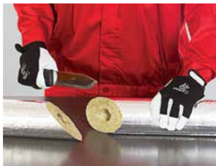
5. kép – A csőhéjat két 45°-os elemre vágjuk
