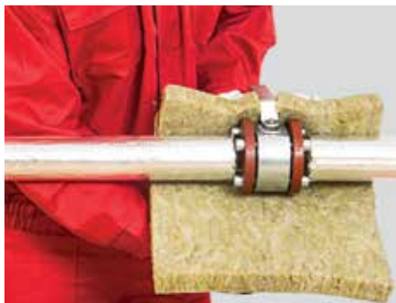
21. kép – A szelep körbeburkolása KLIMAMAT lamellal
