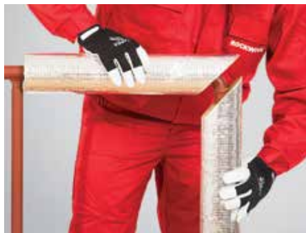
7. kép – Szigetelő elemek összeillesztése
