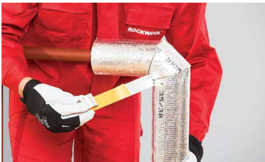
13. kép – Illesztések összeragasztása alumínium öntapadó szalaggal
