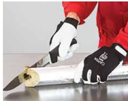
16. kép – 2x45°-os ék levágása a becsatlakozás helyén
