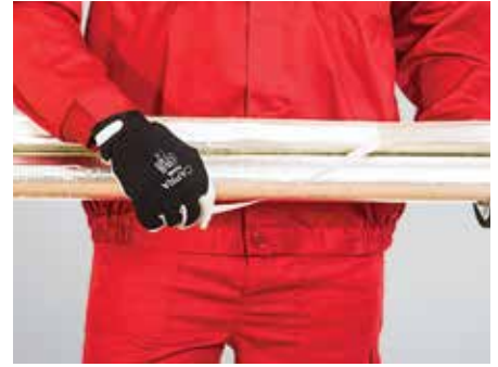
2. kép – A PE védőfólia eltávolítása az öntapadó felületről
