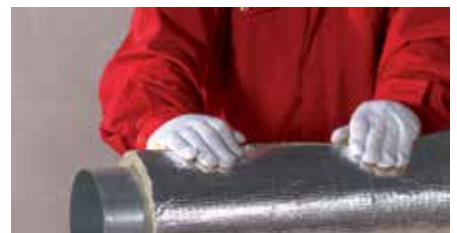
2. lépés – A szigetelés ráhajtása a csatornára
