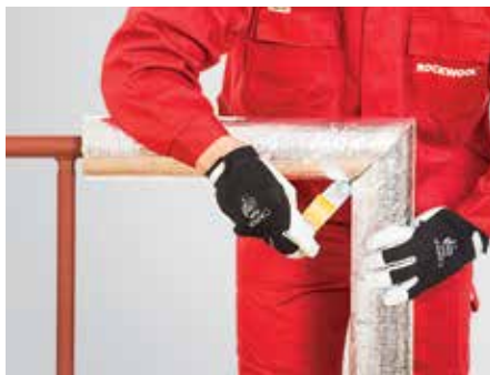
8. kép – Csatlakozások lezárása öntapadó alumínium szalaggal
