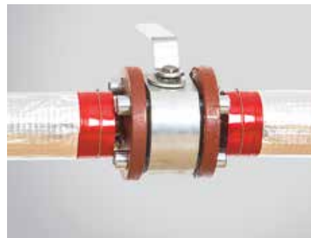
24. kép – Az elkészült szigetelés, ha nincs lehetőség a szelep szigetelésére
