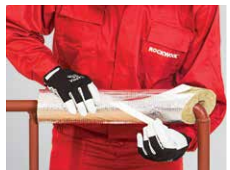
6. kép – A hosszirányú illesztések összeragasztása
