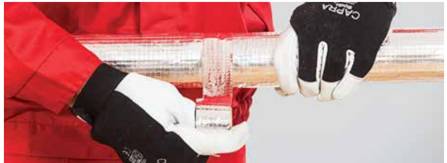
4. kép – Illesztések lezárása alumínium szalaggal
