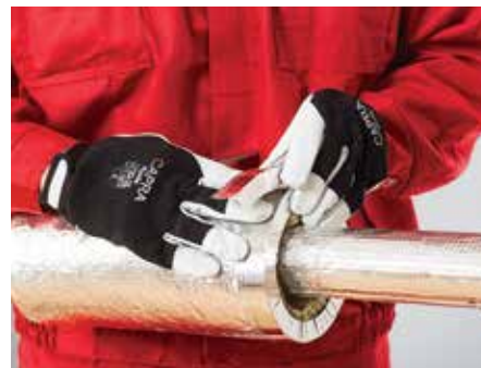
22. kép – A szigetelés lezárása alumínium szalaggal
