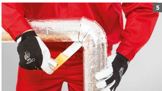
Přelepení spojů kolena hliníkovou páskou
