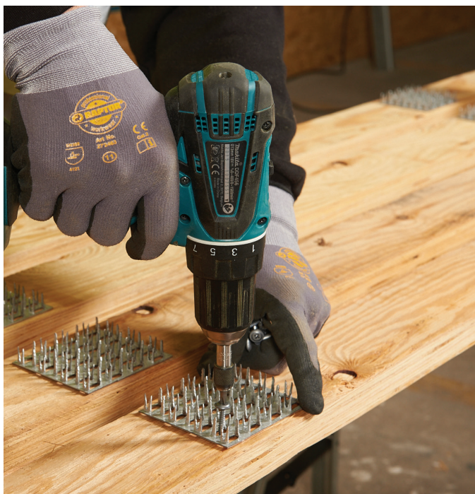
Asenna kitkalevyt rangan taustapuolelle.
