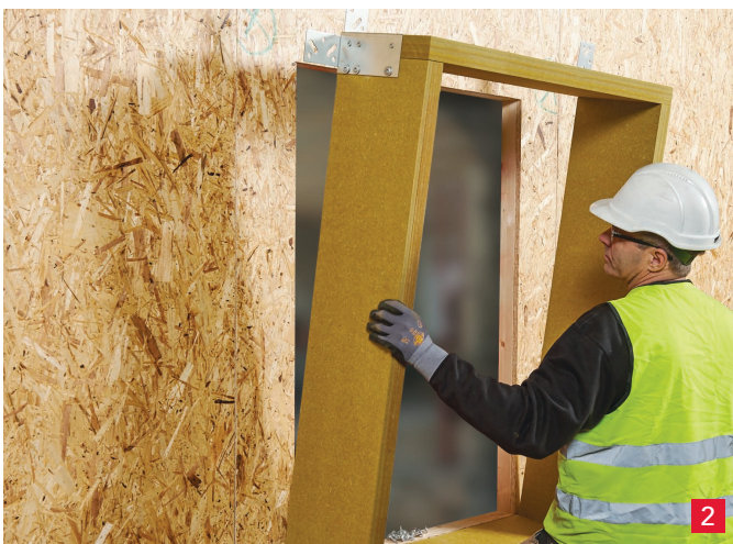
Redair Link -järjestelmä nostetaan paikalleen.
