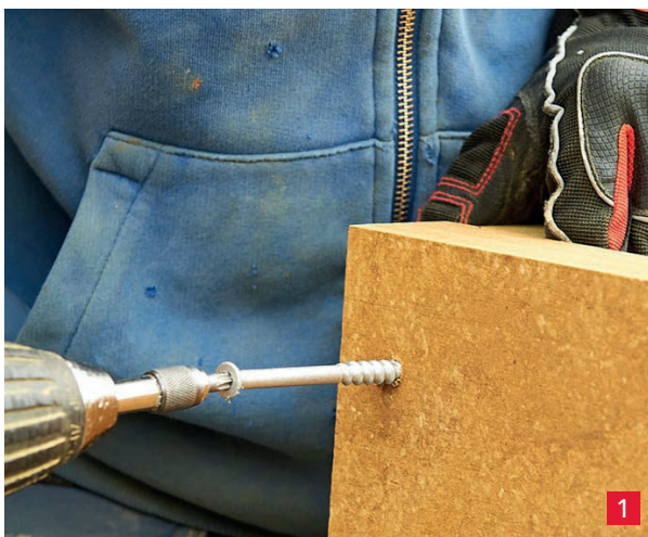
Levyt kiinnitetään toisiinsa ruuvilla ennen kulmakiinnikkeen asennusta.
