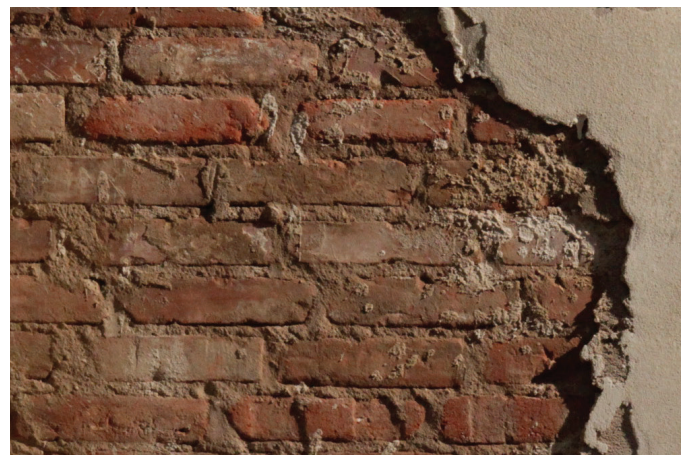
Eksempel på vegg som kun ved en stor innsats kan utbedres slik at kravene tilfredsstilles.
