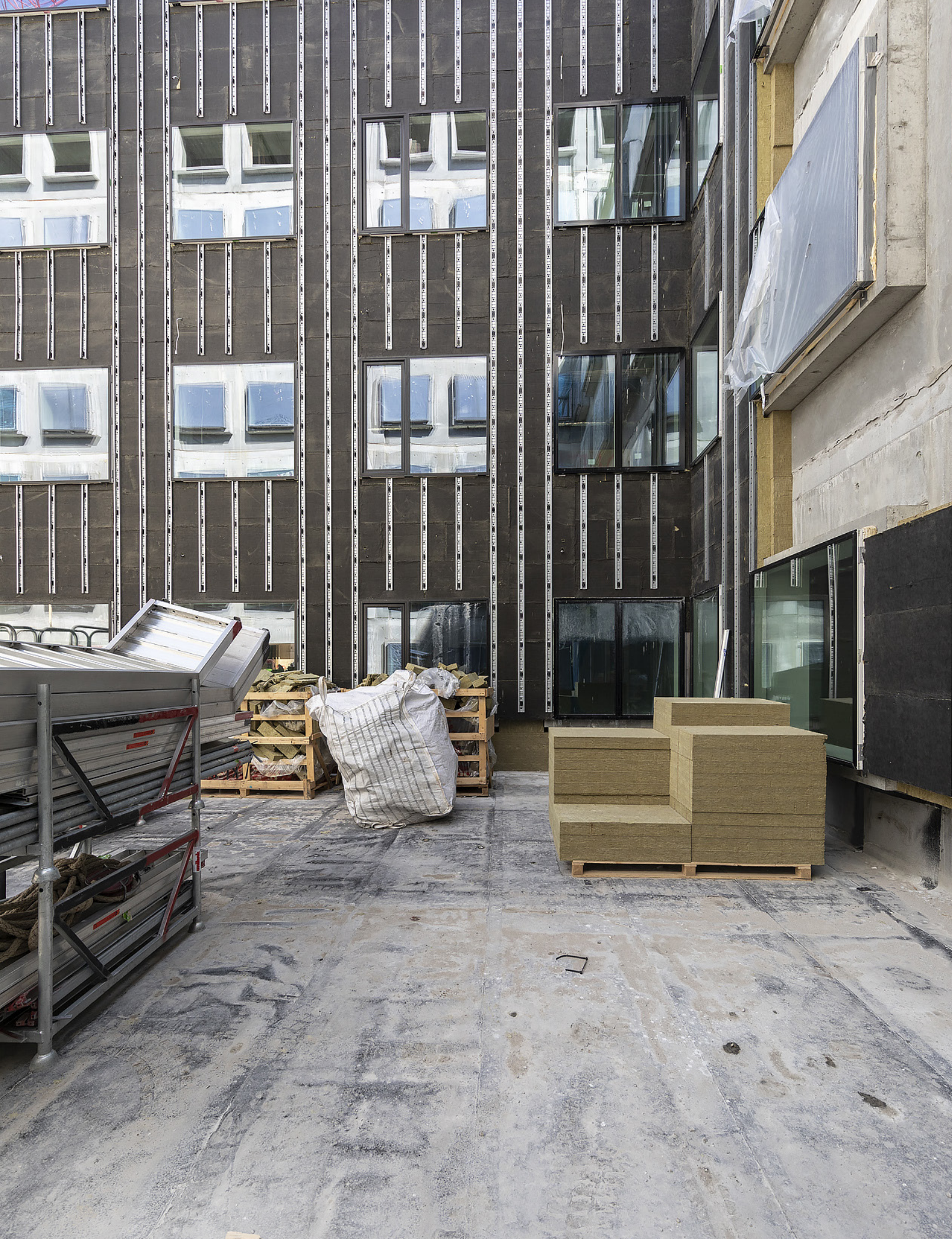
På Kay Fiskers Plass i Danmark har man anvendt ROCKWOOL sitt REDAir Multi system.
